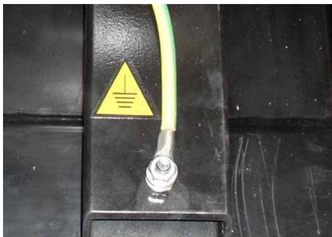
Figura 16 - Ligação à Terra
