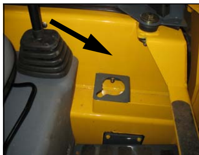
Figura 1 – Localização do extintor de incêndios
