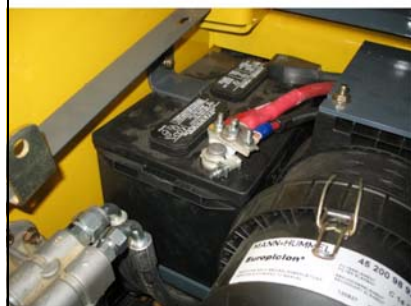
Figura 57 – Localizações da bateria
