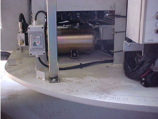
Foto 11 - Geratriz içada e presa no cesto
